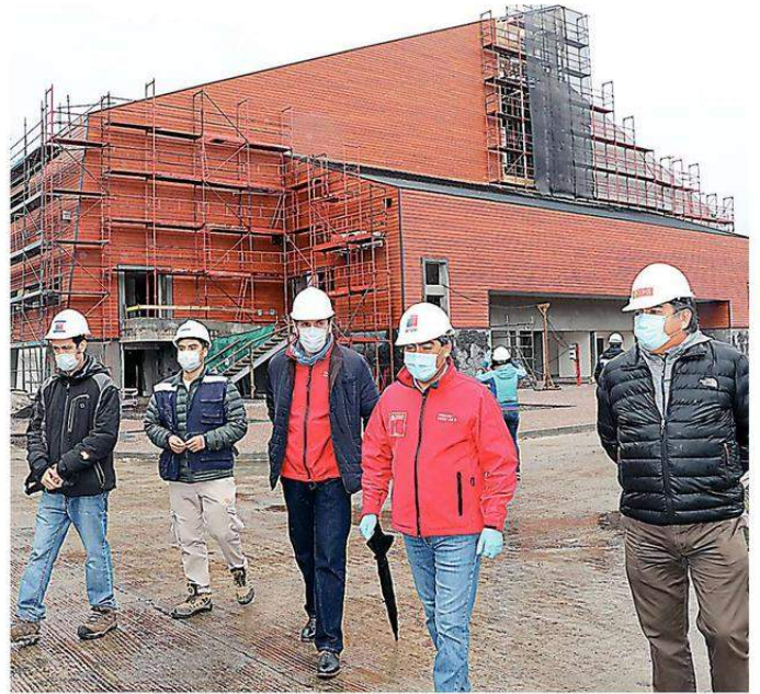
LAS AUTORIDADES DESTACARON EL AVANCE DE LAS OBRAS DEL RECINTO DEPORTIVO REGIONAL.
