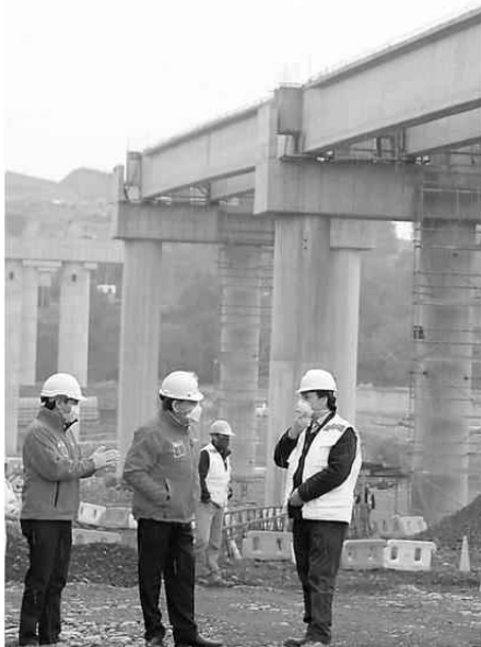
EL PUENTE ES UNA DE LAS OBRAS MÁS GRANDES QUE SE DESARROLLAN EN LA REGIÓN.
